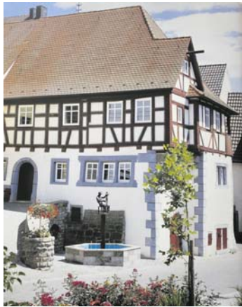
Haus der Familie Kern, 1989, nach der Renovierung, Forchtenberg, Hafnenmarktgasse 29
